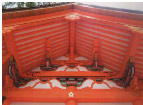
上：向拝中央間見上げ 上右：海老虹梁元口絵様 下：同上虹梁型出桁・龍彫刻
