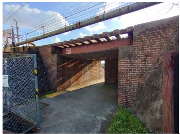
下り線側（橋梁）
