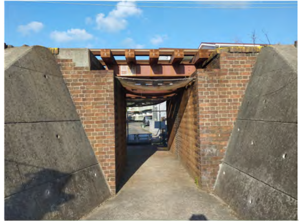
上り線側（開渠）
