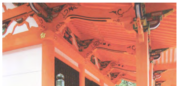
海老虹梁の細部様式も中央と両脇でことなり、中央元口の多重の木瓜紋と若葉の飛び方も珍しい
