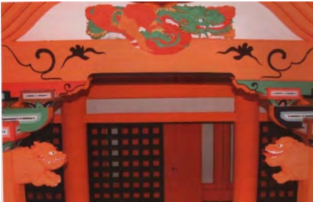
上：向拝中央間見上げ 上右：海老虹梁元口絵様 下：同上虹梁型出桁・龍彫刻
