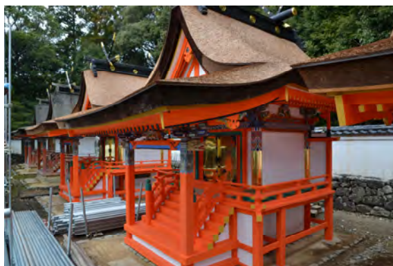
図4 寶來山神社本殿(摂社東殿の前から西を見る)
