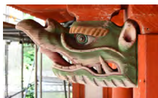
東田中神社境内社旧竹房神社本殿(向拝) 室町後期～桃山時代
