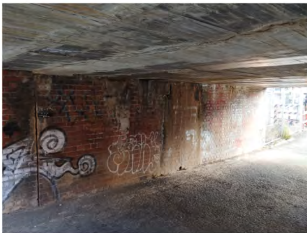
写真1 宇治架道橋 (北側橋台)
