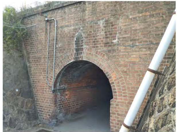
写真2 宇治拱渠 (西側ポータル部)
