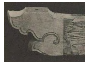
野上八幡宮本殿(向拝) 元龜3年(1572)
